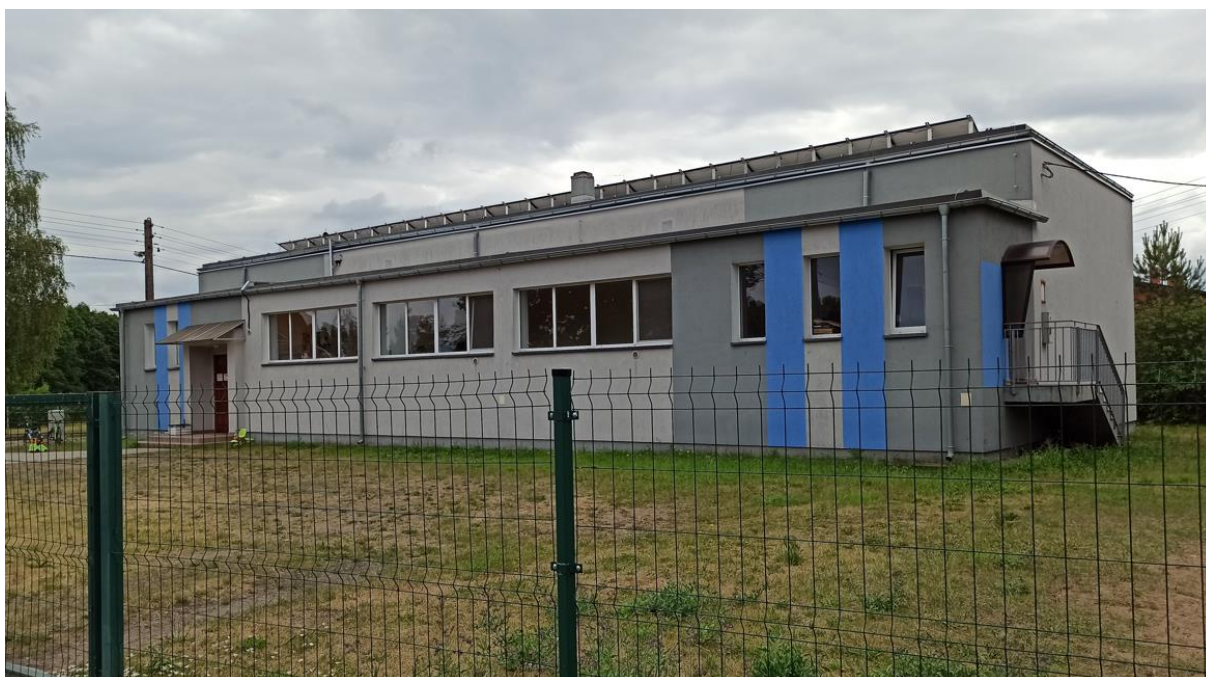
Rycina 13 Budynek świetlicy wiejskiej w Breniu
